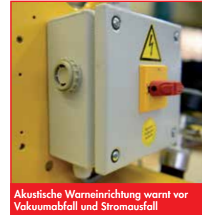
Hauptschalterüberwachung über einen Vakuum-Schalter in der Verteilerleitung
