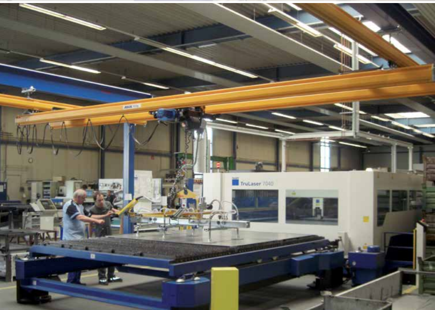
Zweiträger-Hängebahnsystem mit elektrischem Reibradantrieb und einem Vakuumhandhabungsgerät VacuBoy
