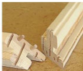
Flügelprofil auf Gehrung ablängen, Keilnuten für Schwalbensitz einfräsen, Dübellöcher bohren, Dübel einsetzen
