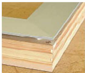
Vormontierten Aluminiumrahmen aufsetzen
