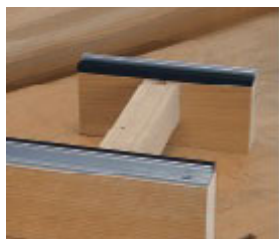
Glasträgerschiene aufsetzen und verschrauben
