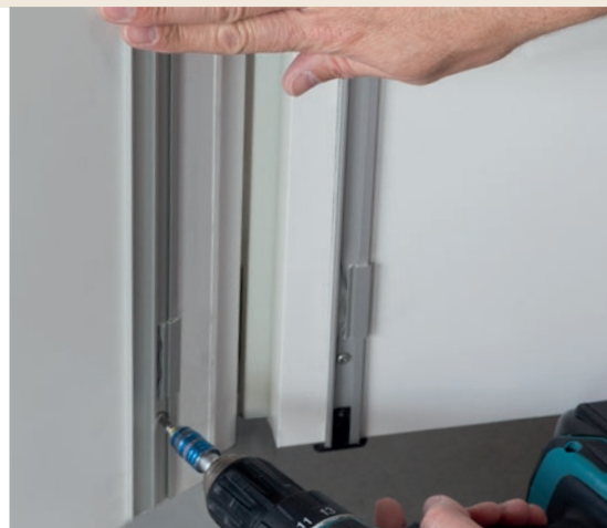
* 1. építési fázis - csak szerelősínekkel szerelve
